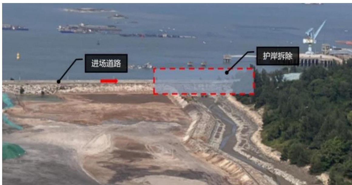
对原有护岸进行破口，修建一条临时围堰施工便道
